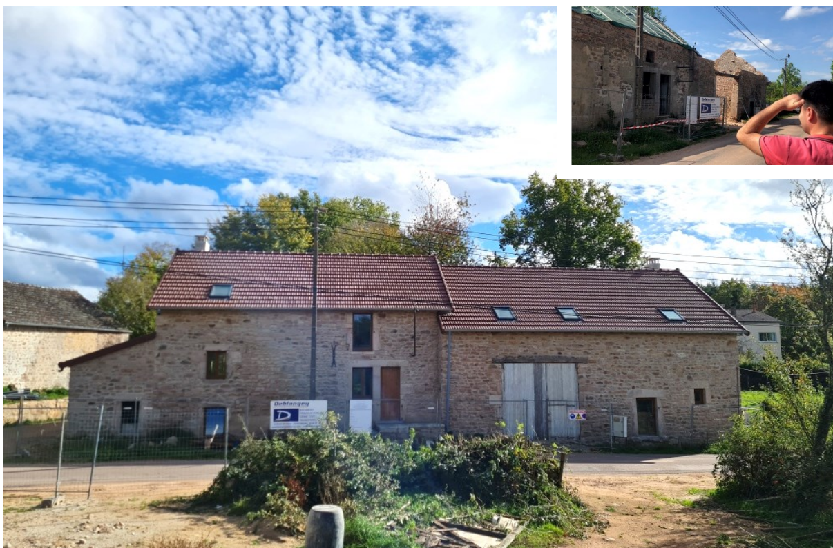
Le chantier en mai 2021 (en haut à droite) et avancement des travaux au 24 octobre 2022.
